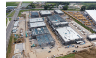
坂東製造事業所の建設現場
