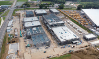
坂東製造事業所の建設現場
