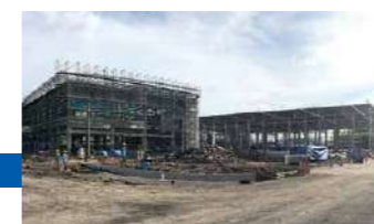
建設中の大日カラー・タイランドLTD.新工場
