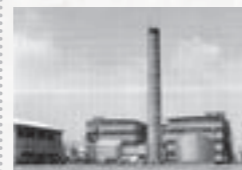
第1期工事竣工時の東海製造事業所
