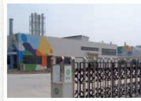
大日精化(上海)化工有限公司の外観
