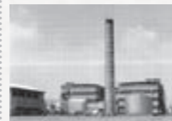
第1期工事竣工時の東海製造事業所
