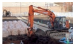
北海道事業所跡地での土壌掘削除去
