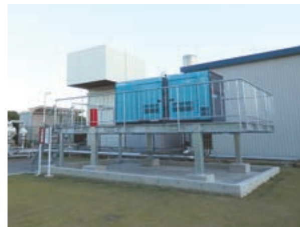
停電時にコージェネレーションが操業できるように起動システムを導入しました
